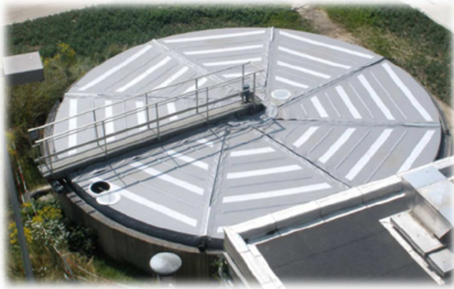
Figure 26 : Exemple de couverture catalytique
