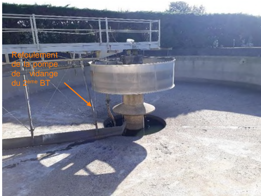
Figure 24 : Fonctionnement de la vidange actuelle du 2 ème bassin tampon
