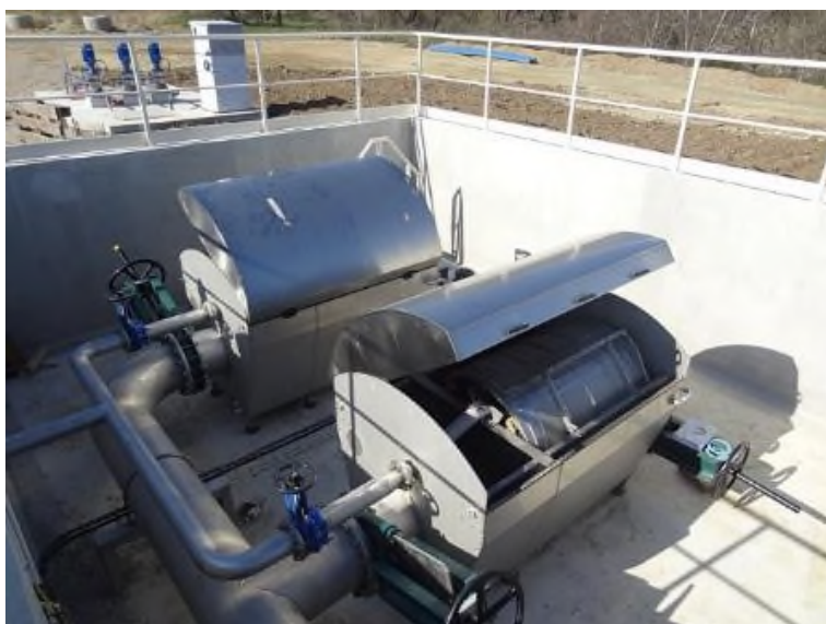
Figure 22 : Exemple de filtres à tambour rotatif
